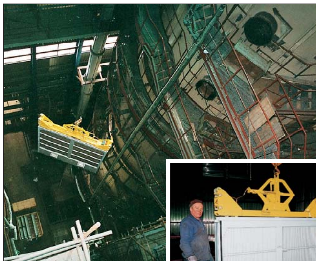
正在烟气脱硫系统中进行安装的LTH100
