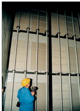
在烟气脱硫系统中安装完毕的LTH100
