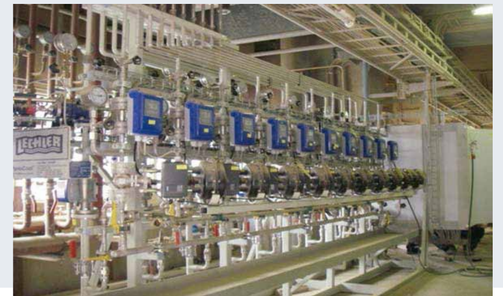
超高效型SNCR系统使用的控制阀组
